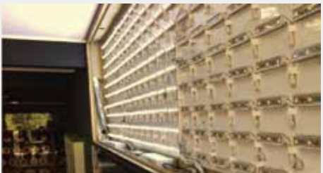
薄型サインで看板内収納 (LEDモジュールの熱とも干渉してしまう)
