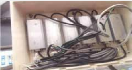
収納BOXに密集した状態で収納 (各LED電源の発熱で相乗効果により温度が高くなってしまう)
